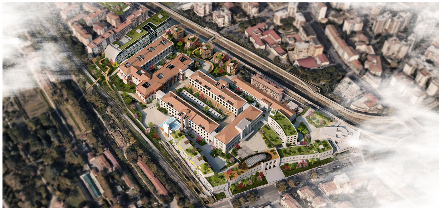
Manifattura Tabacchi Via delle Cascine,5, Firenze years: 2017 mq: 100000 client: Aermont London
